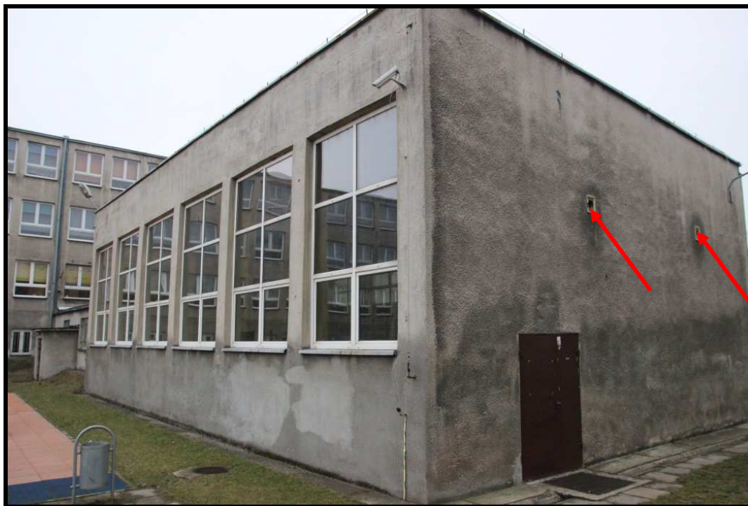
Fotografia 9: Widok na południową oraz zachodnią elewację sali gimnastycznej z zaznaczonymi potencjalnymi miejscami gniazdowania ptaków w otworach wentylacyjnych.
