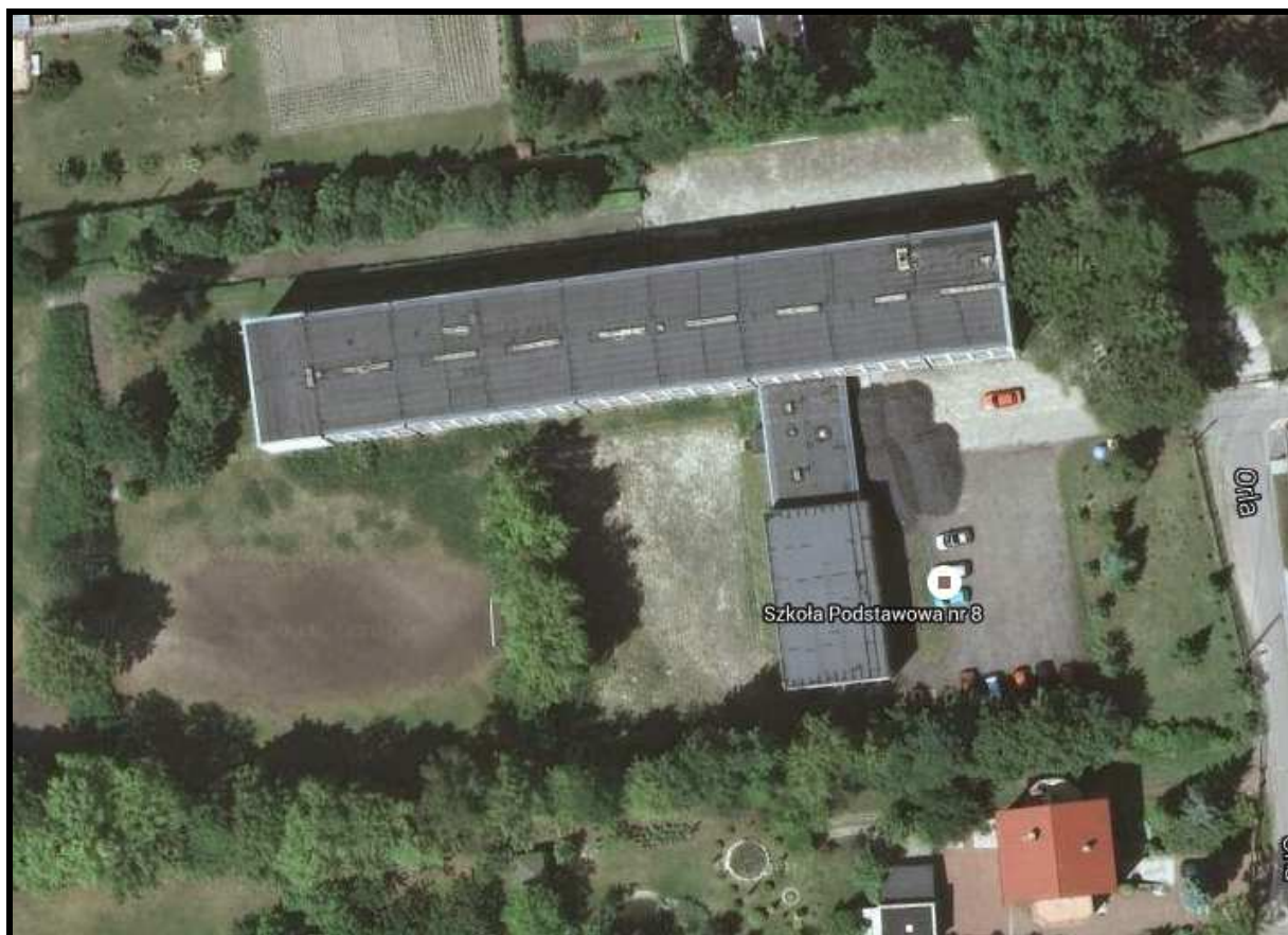
Rysunek 1: Orientacyjna mapa pokazująca lokalizację budynku, dla którego przeprowadzono inwentaryzację oraz przedstawiająca teren na którym mają zostać wycięte drzewa.
