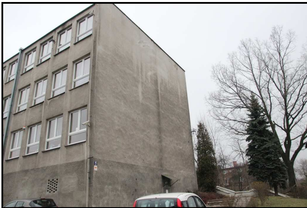
Fotografia 1: Widok przedstawiający wschodnią elewację budynku dydaktycznego objętego inwentaryzacją.
