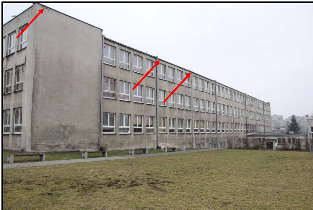
Fotografia 5: Widok na południową elewację budynku objętego inwentaryzacją wraz z zaznaczonymi trzema szczelinami mogącymi służyć za potencjalne miejsca gniazdowania ptaków.
