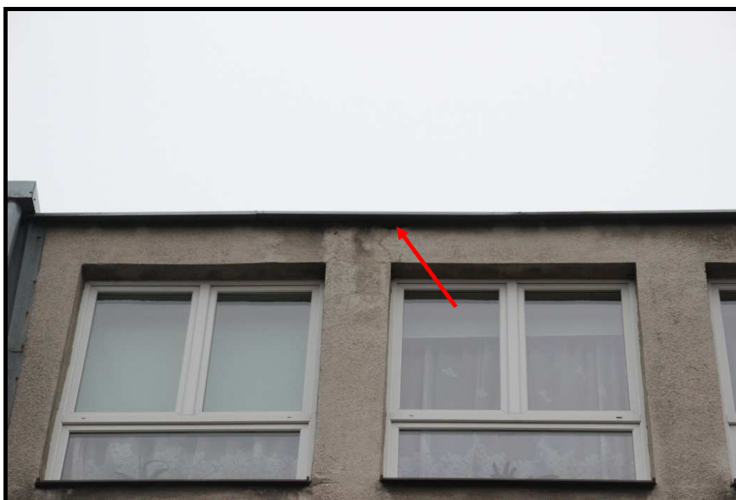
Fotografia 7: Zdjęcie przedstawiające w powiększeniu drugie z trzech potencjalnych miejsc gniazdowania ptaków na południowej elewacji.
