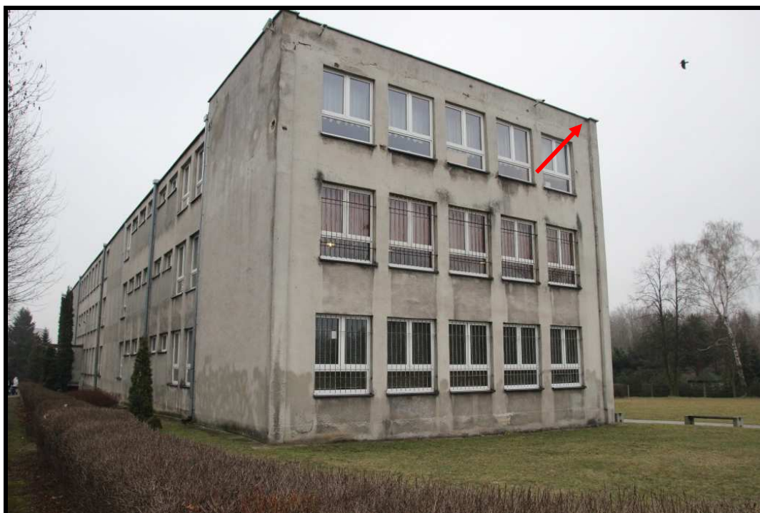
Fotografia 3: Widok na zachodnią elewację budynku objętego inwentaryzacją. Zaznaczono potencjalne miejsce gniazdowania.
