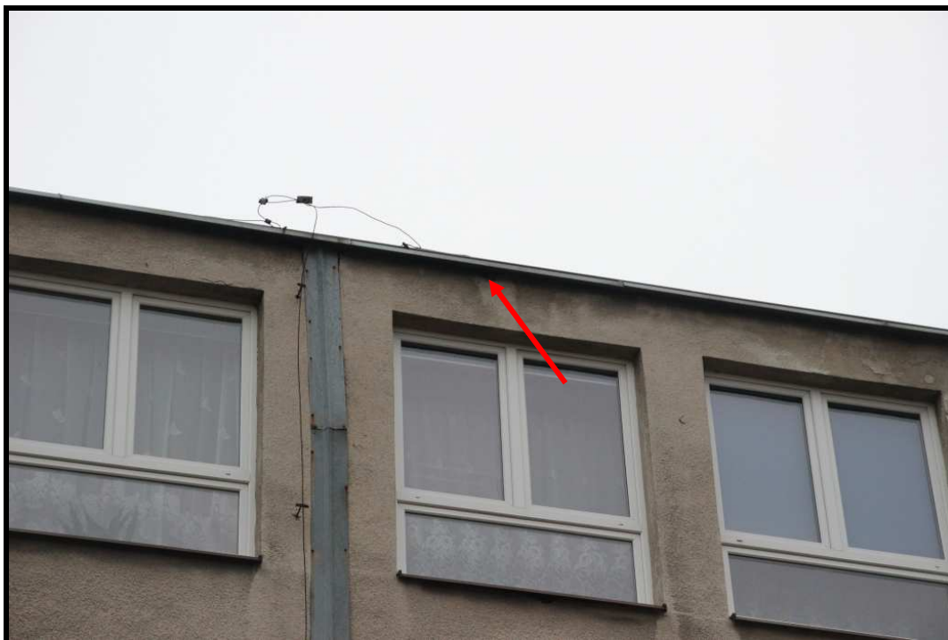
Fotografia 7: Zdjęcie przedstawiające w powiększeniu trzecie z trzech potencjalnych miejsc gniazdowania ptaków na południowej elewacji.
